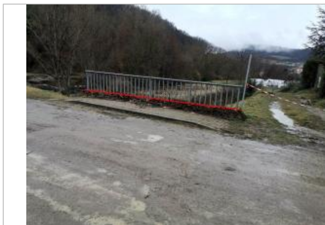
Laisse de crue sur le pont du lac - Photo ©AGERIN
