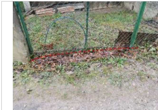
Débris végétaux sur un grillage - Photo ©AGERIN
