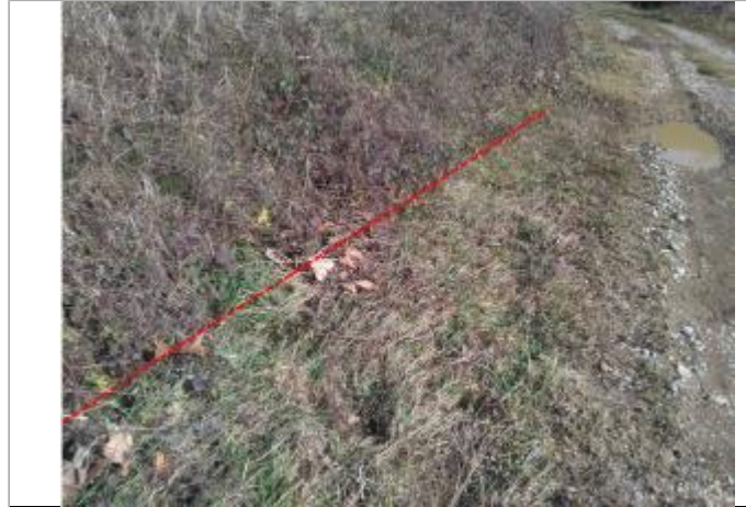
Hauteur d'eau sur la digue du chemin du Menechal - Photo ©AGERIN
