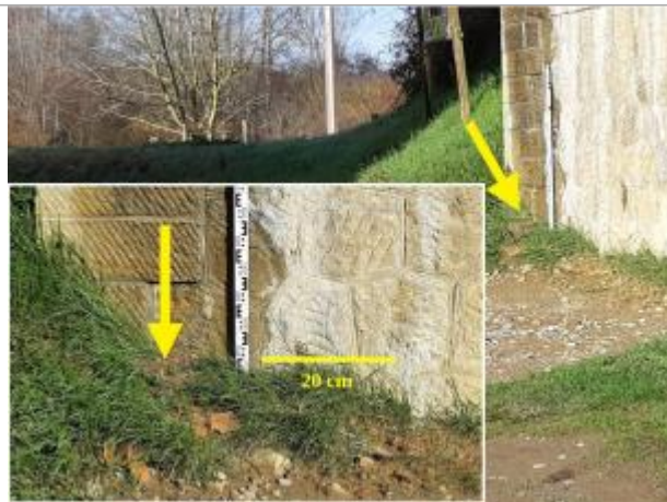
Pile de droite du pont de la voie verte - Photo ©SBGH
