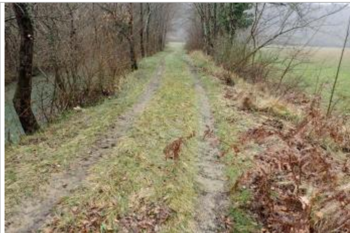
Berge rive droite - Photo ©AGERIN
