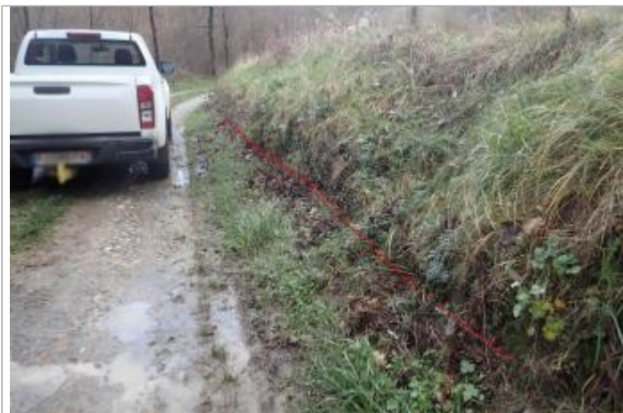
Talus rive droite - Photo ©AGERIN
