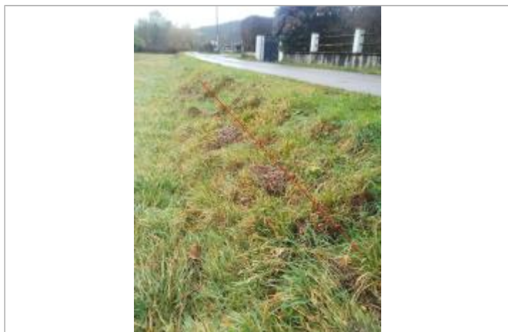
Laisse d'inondation sur la digue - Photo ©AGERIN
