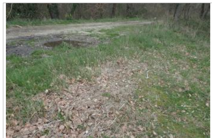
Débris végétaux au sol - Photo ©AGERIN
