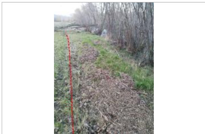
Débris végétaux au sol - Photo ©AGERIN
