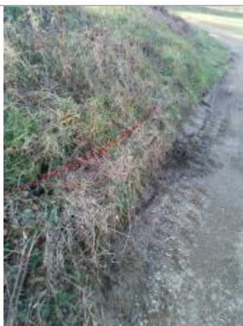
Laisse d'inondation sur la digue - Photo ©AGERIN
