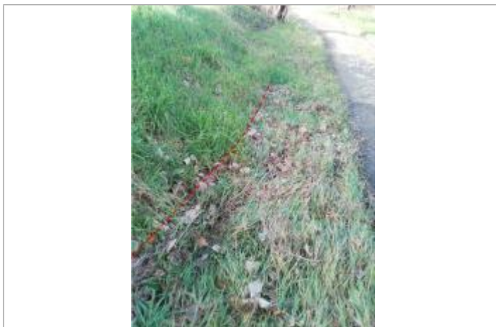
Digue rive gauche de l'Hers - Photo ©AGERIN
