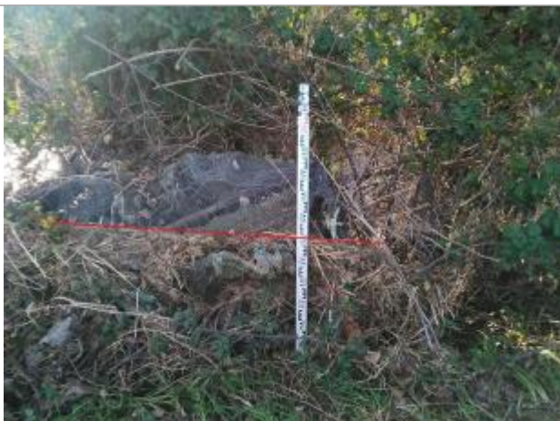
Laisse de crue sur le grillage - Photo ©AGERIN
