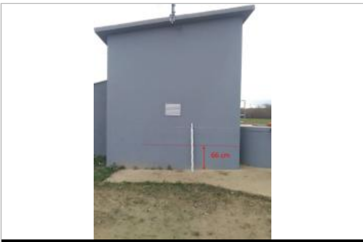
Mur de la station de captage - Photo ©AGERIN
