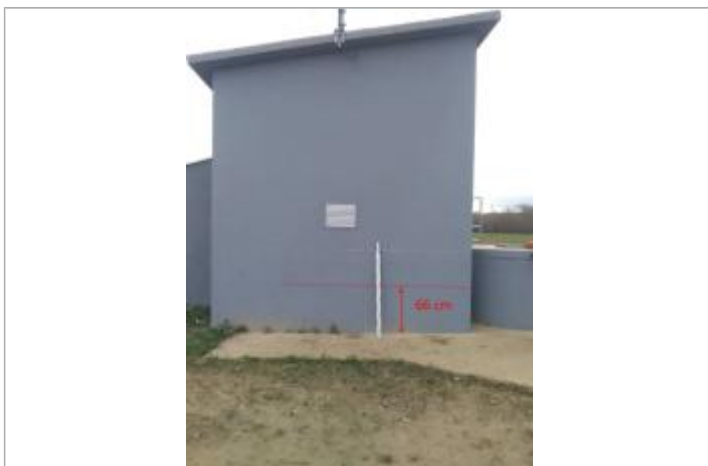
Laisse d'inondation sur le mur - Photo ©AGERIN
