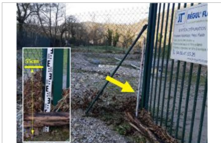
Laisse de crue sur le grillage - Photo ©SBGH
