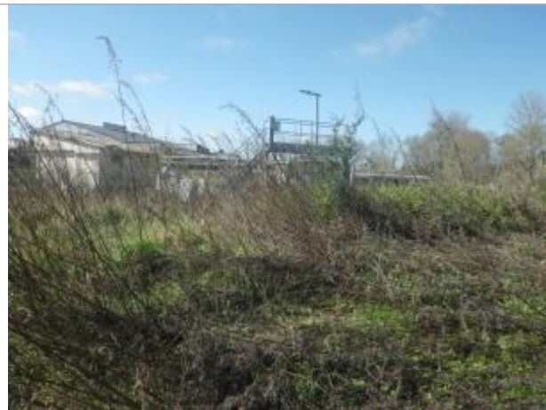
Station d'épuration de Mirepoix - Photo ©AGERIN
