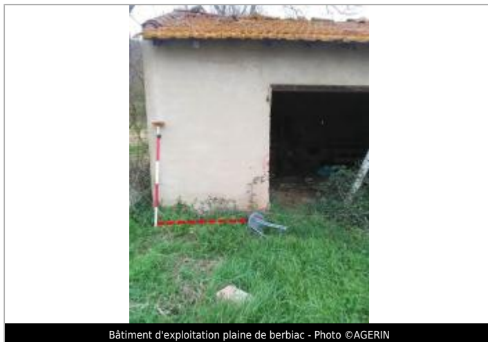
Bâtiment d'exploitation plaine de berbiac - Photo ©AGERIN
