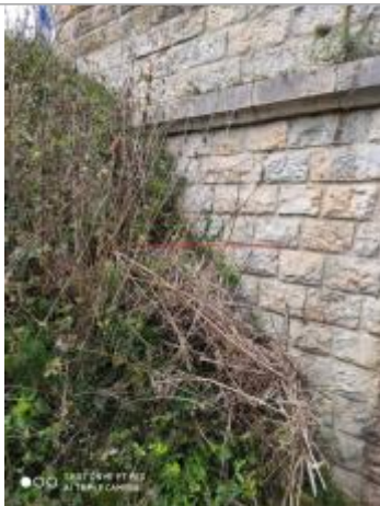
Laisse de crue culée du pont - Photo ©AGERIN
