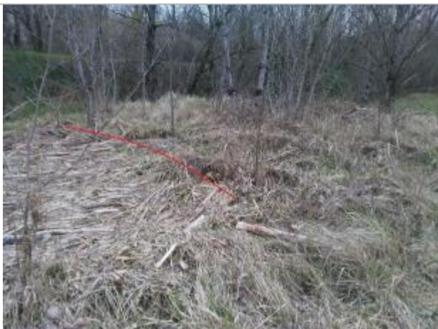
Débris végétaux sur un talus - Photo ©AGERIN
