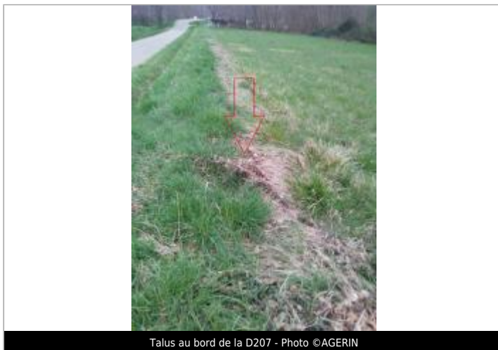
Talus au bord de la D207 - Photo ©AGERIN
