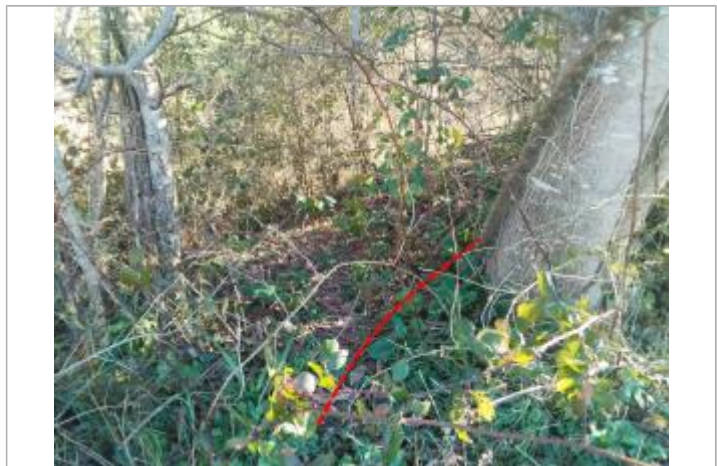
Débris végétaux en haut de talus - Photo ©AGERIN
