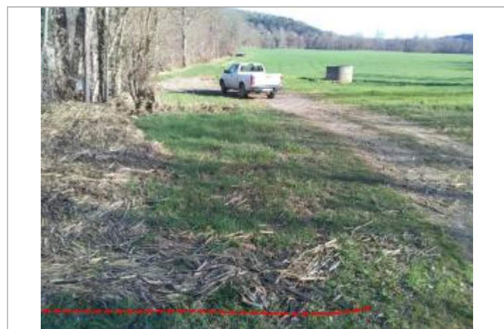
Débris végétaux sur le chemin d'exploitation - Photo ©AGERIN
