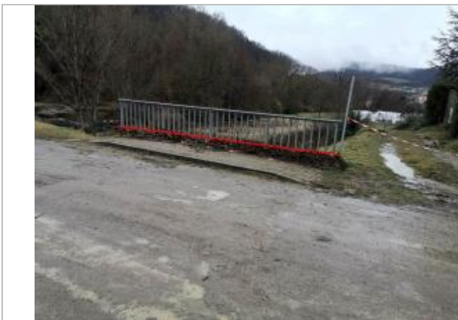
Pont aval du lac de Chalabre - Photo ©AGERIN
