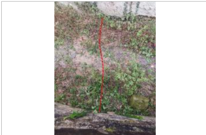
Descente amont du pont du Blau en rive gauche - Photo ©AGERIN
