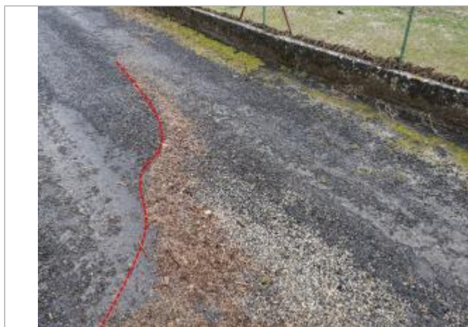
Laisse de crue au sol - Photo ©AGERIN
