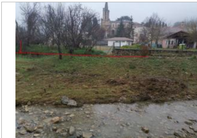
Berge rive droite du Chalabreil - Photo ©AGERIN
