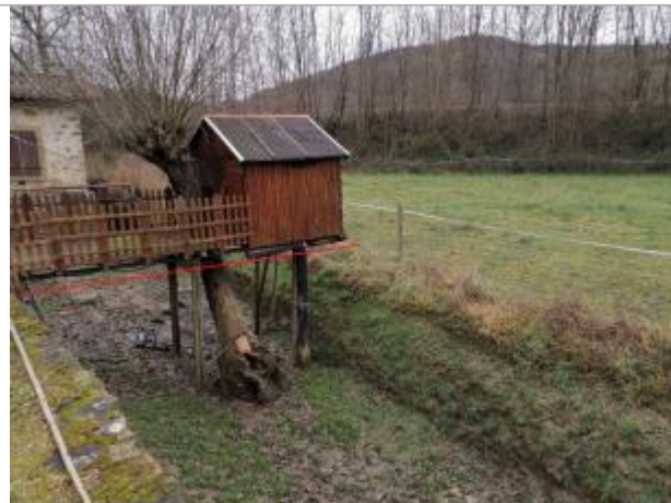
Canal au 8 route de Mirepoix - Photo ©AGERIN
