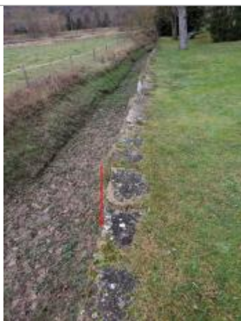
Témoignage riverains 15 cm en dessous du haut de berge - Photo ©AGERIN
