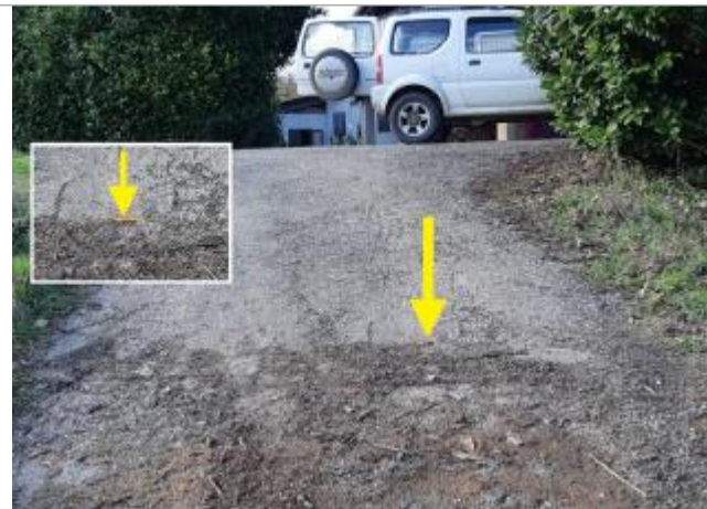
Descente de la digue aval - Photo ©SBGH
