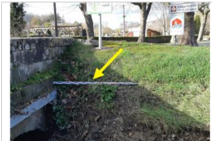
Intersection RD7 avec la digue de Camon - Photo ©SBGH
