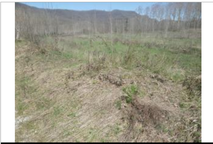
Digue champs rive gauche - Photo ©AGERIN
