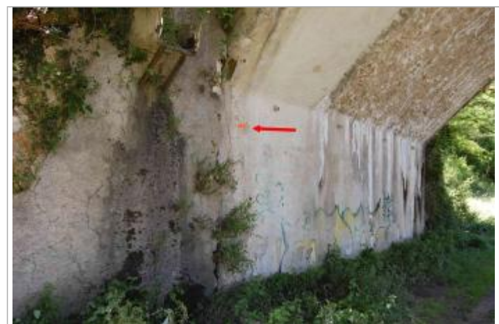
Vue du repère - Géosphair
