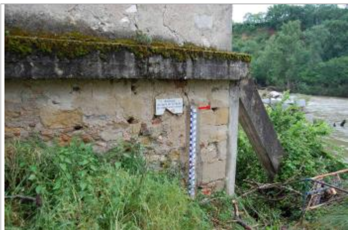
Vue du repère - Géosphair
