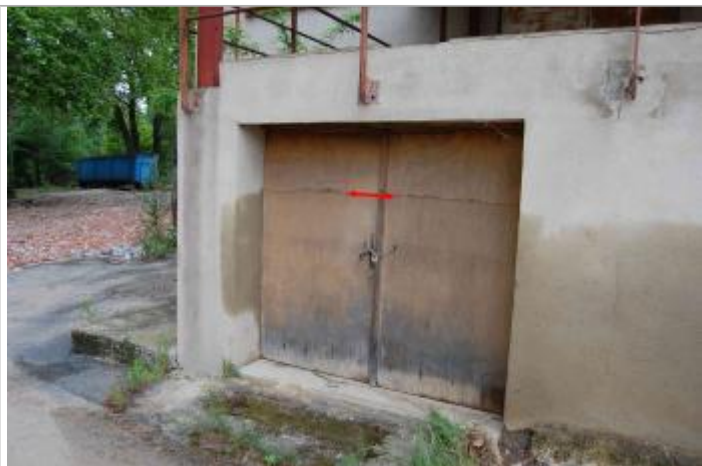
Vue du repère - Géosphair
