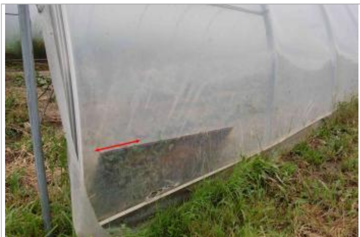
Vue du repère - Géosphair
