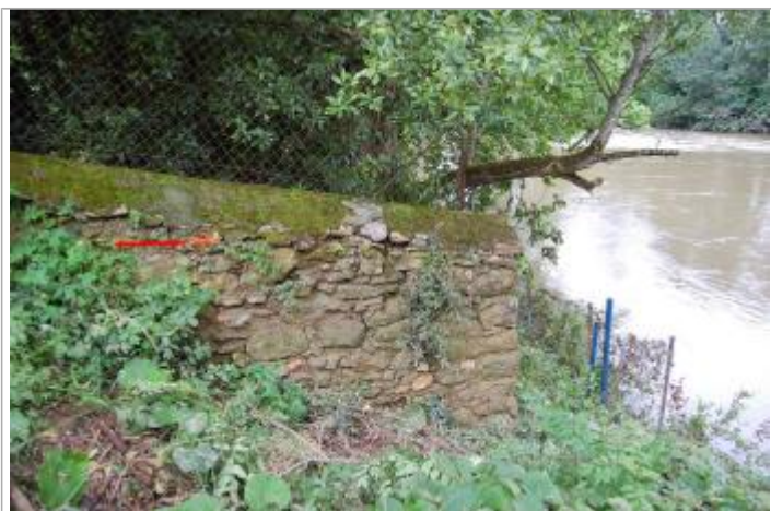
Vue du repère - Géosphair
