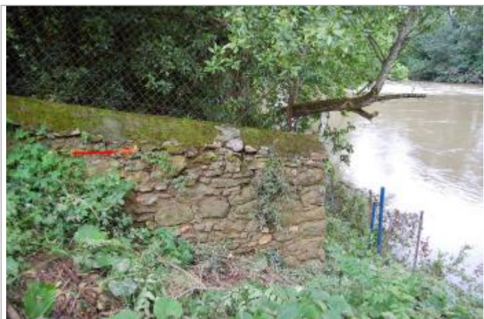
Vue du repère - Géosphair
