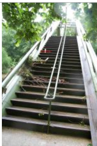
Vue du repère - Géosphair
