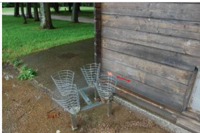
Vue du repère - Géosphair
