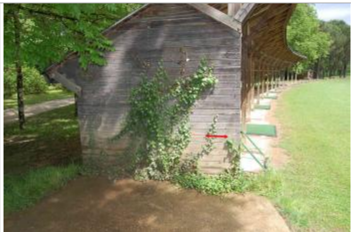
Vue du repère - Géosphair
