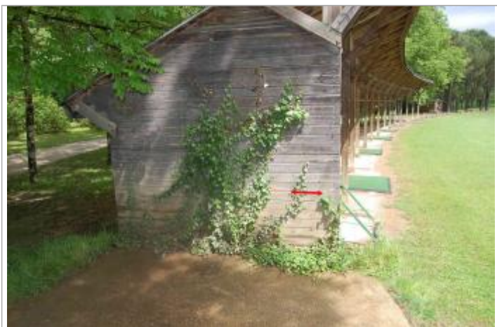
Vue du repère - Géosphair
