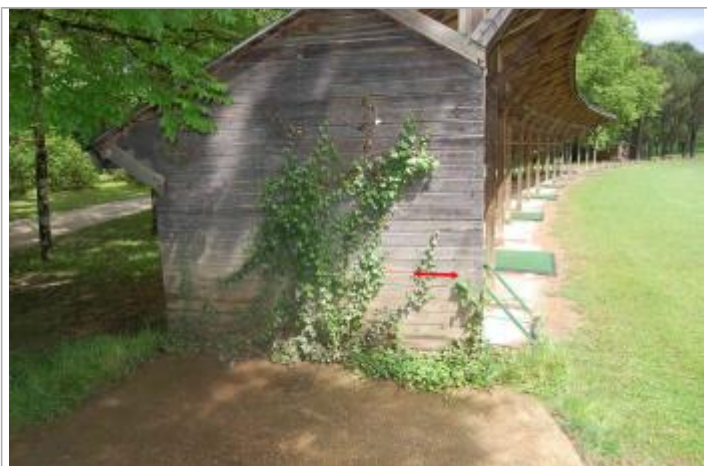
Vue du repère - Géosphair
