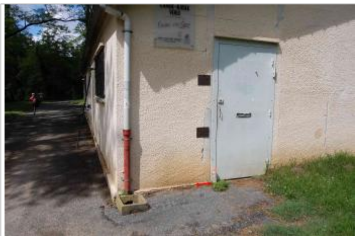
Vue du repère - Géosphair
