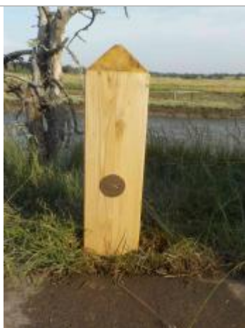
Implantation du repère sur une borne en bois au bord de l'apiste cyclable sur la route du Veillon
