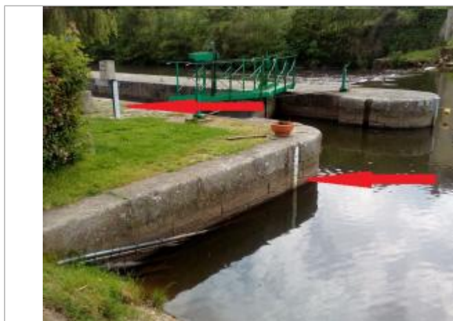
échelle limnimétrique de la station Vigicrues de Josselin amont écluse
