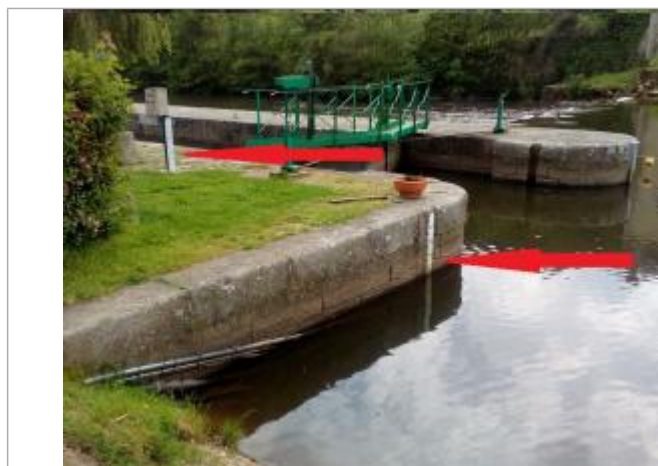
échelle limnimétrique de la station Vigicruces de Josselin amont écluse
