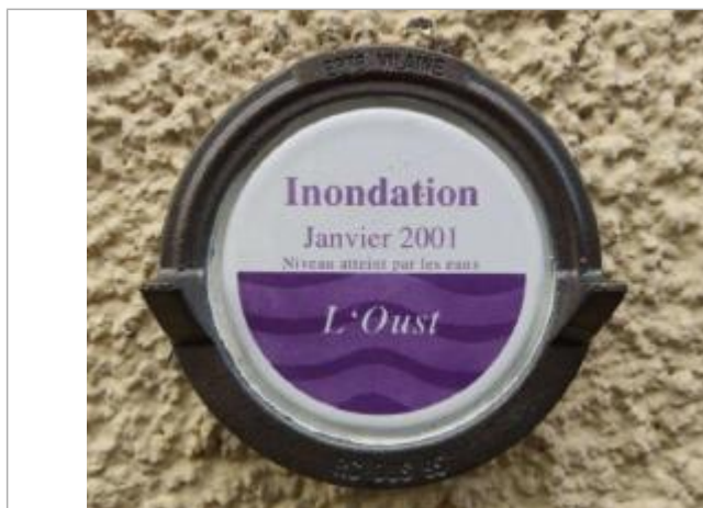
Repère normalisé inondation janvier 2001
