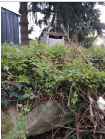
laisses de crue côté rivière - environ 15cm sous la crête du merlon
