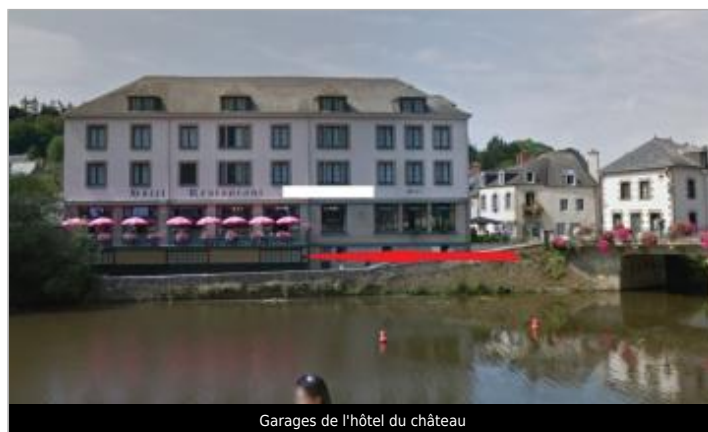
Garages de l'hôtel du château
