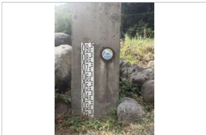
Plot béton avec échelle limnimétrique et repères de crue, DEAL Réunion, 2023
