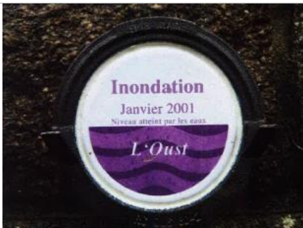
Repère de crues normalisé de janvier 2001
