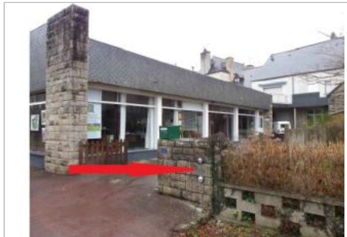
Muret d'entrée du 71 rue Glatinier coté chemin de halage de la rivière Oust
