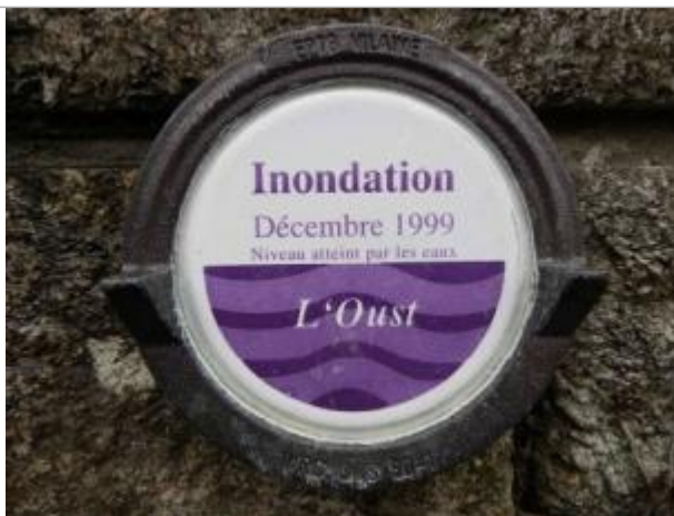
Repère de crue normalisé de décembre 1999
