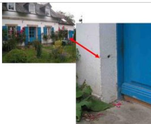
Marque sur la porte « amont ».
