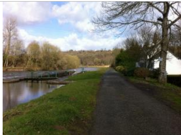
Vue d'ensemble de la maison de l'écluse
