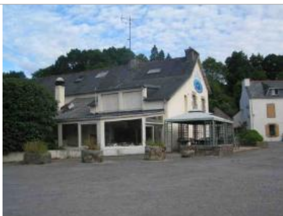
180 cm d'eau dans la véranda en 2000.
